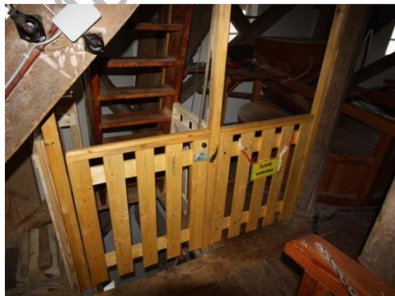
Bild 9: Sicherung der Treppenluken
