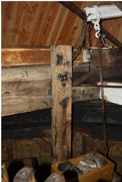
Bild 4: Aufhängungen zwischen Fangstock und Bremsbalken
