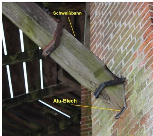
Bild 8: Abdichtung an den Schoren der Galerie
