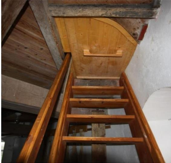
Bild 10: Gesicherter Treppenaufgang mit Lukenabdeckung
