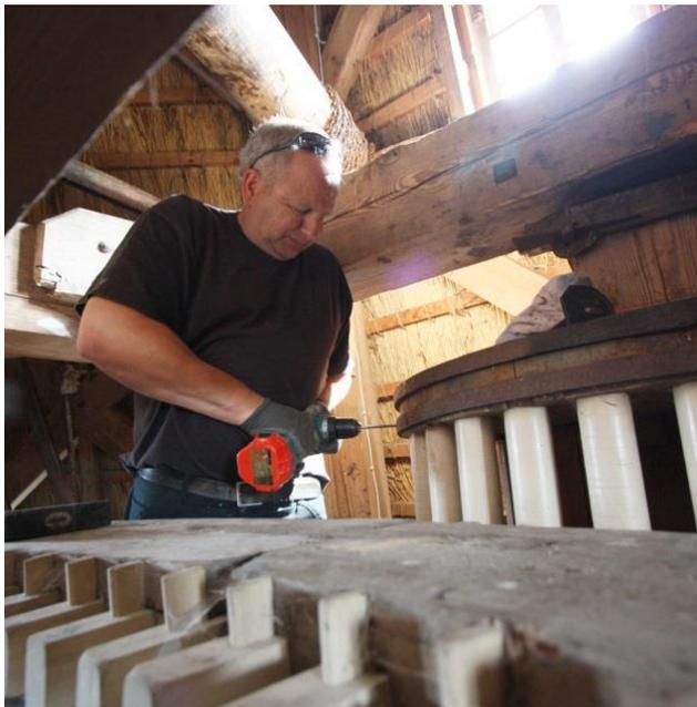
Bild 7: Sicherungsringe am Korbrad positionieren
